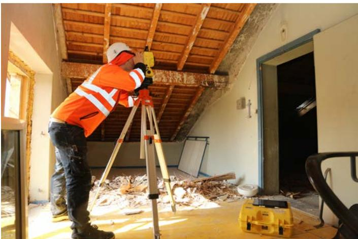
Im Dachstock wird ausgemessen für den Dachanschluss mit dem neuen Anbau.
