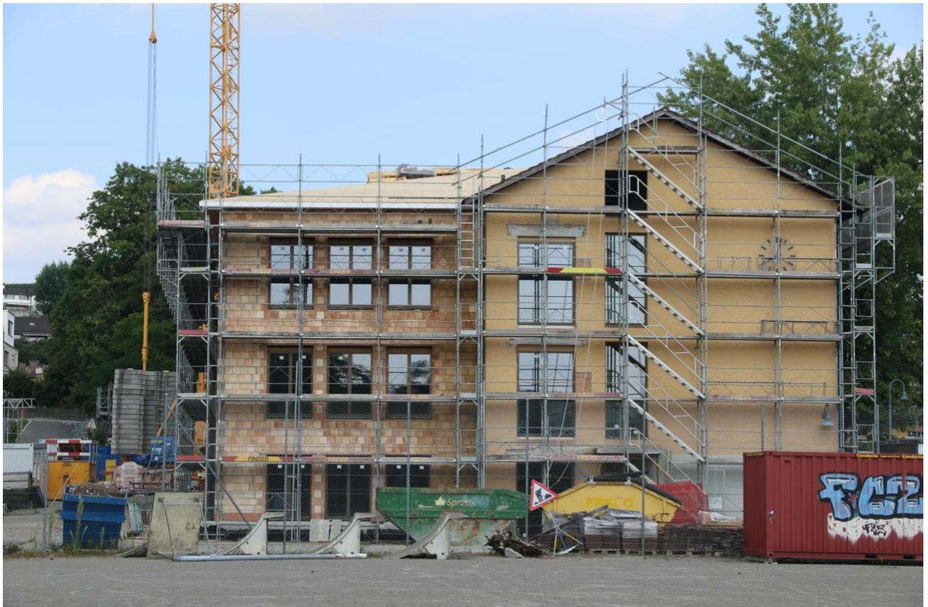
Der Dachstuhl beim Anbau ist errichtet – bald kann das Dach eingedeckt werden.
