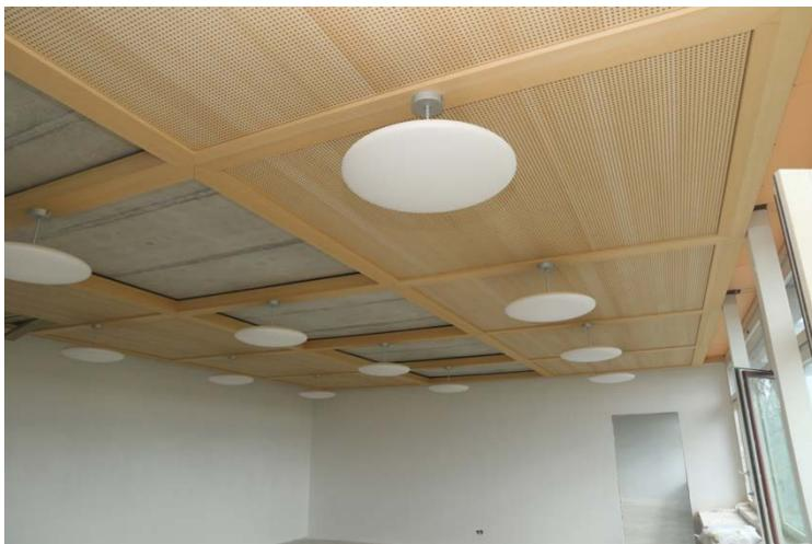
Im Musterzimmer ist bereits die Akustikdecke und die LED-Deckenbeleuchtung montiert worden.
