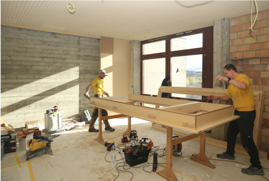
Die Schreiner bereiten die neuen Holztürrahmen der Klassenzimmer für die Montage vor.
