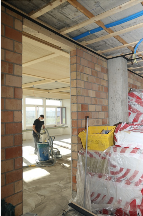
Im Erdgeschoss werden die Böden für den neuen Linoleum-Belag geschliffen.
