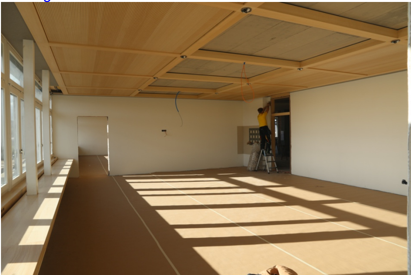
Im zweiten Obergeschoss sind die Arbeiten in den Klassenzimmern fast abgeschlossen.
