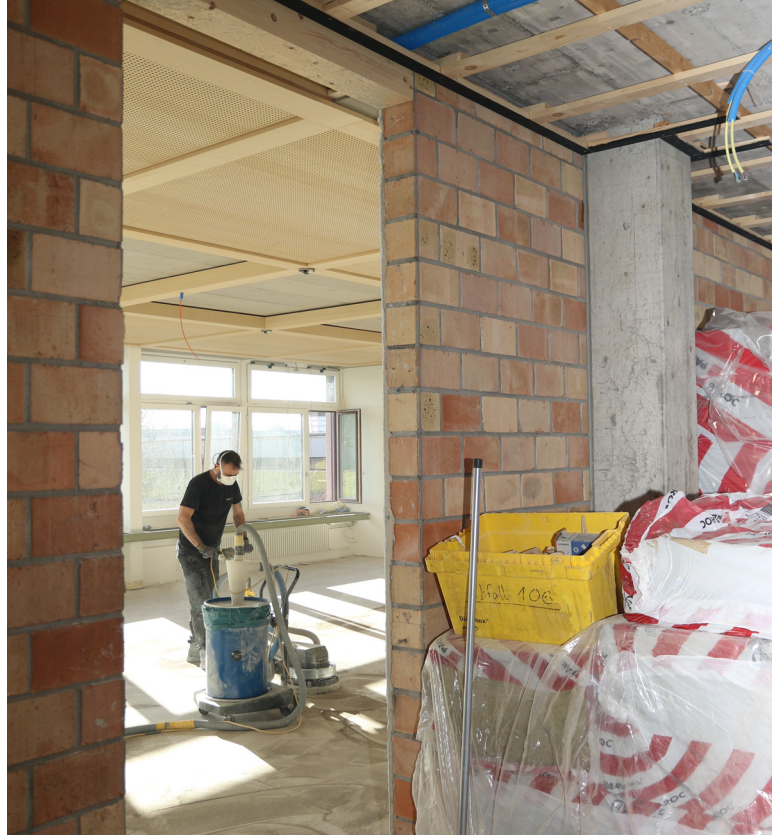
Im Erdgeschoss werden die Böden für den neuen Linoleum-Belag geschliffen. BILDER ZVG
