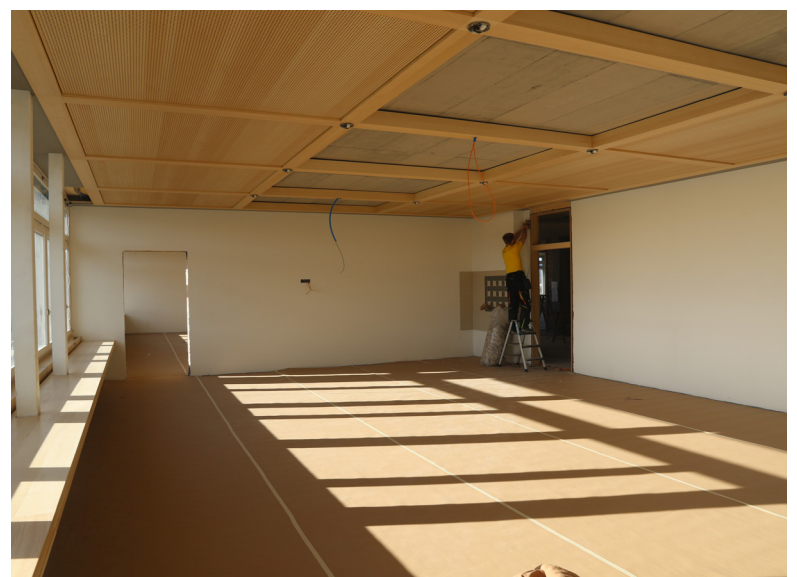
Im zweiten Geschoss sind die Arbeiten in den Klassenzimmern fast abgeschlossen.
