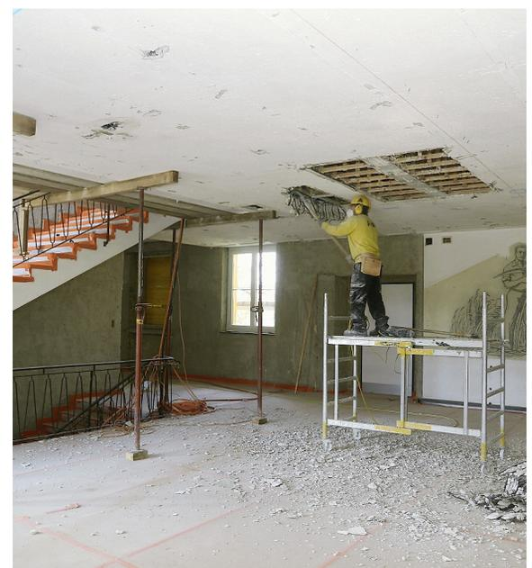
In der Eingangshalle wird die alte Putzdecke entfernt.
