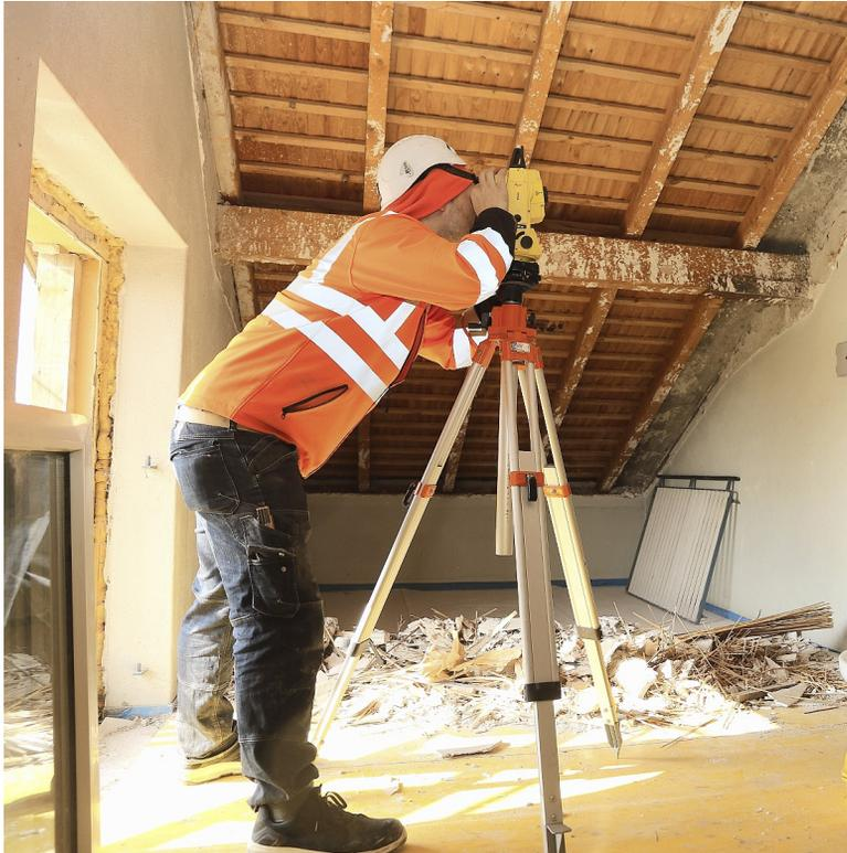
Im Dachstock wird ausgemessen für den Dachanschluss mit dem neuen Anbau.
