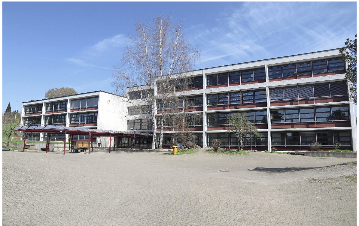
Soll ab 2025 saniert werden: die Schulanlage Feldhof.
