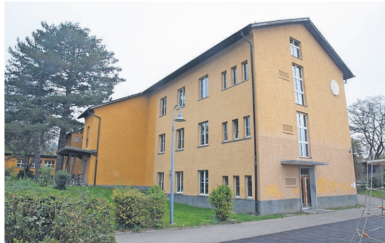
Das Schulhaus Zentral soll an der Rückseite mit einem dreigeschossigen Anbau erweitert werden. Zudem soll das Dachgeschoss ausgebaut werden.
