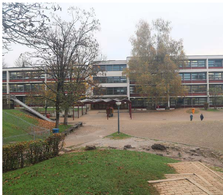
Die 1972 erbaute Schulanlage Feldhof muss umfassend saniert werden. BILDER BEATRICE ZOGG
