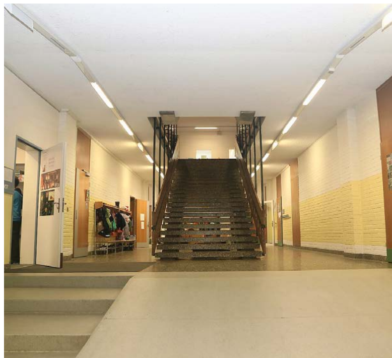
Die heute bestehenden zwei Erschliessungstreppe (eine davon im Bild) nehmen viel Korridorfläche weg. Neu soll eine zentrale Haupttreppe das Schulhaus erschliessen.
