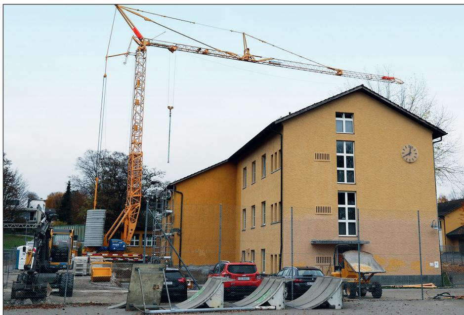
*Der Baukran wurde aufgestellt und die Baugrube für den Anbau ausgehoben.*
